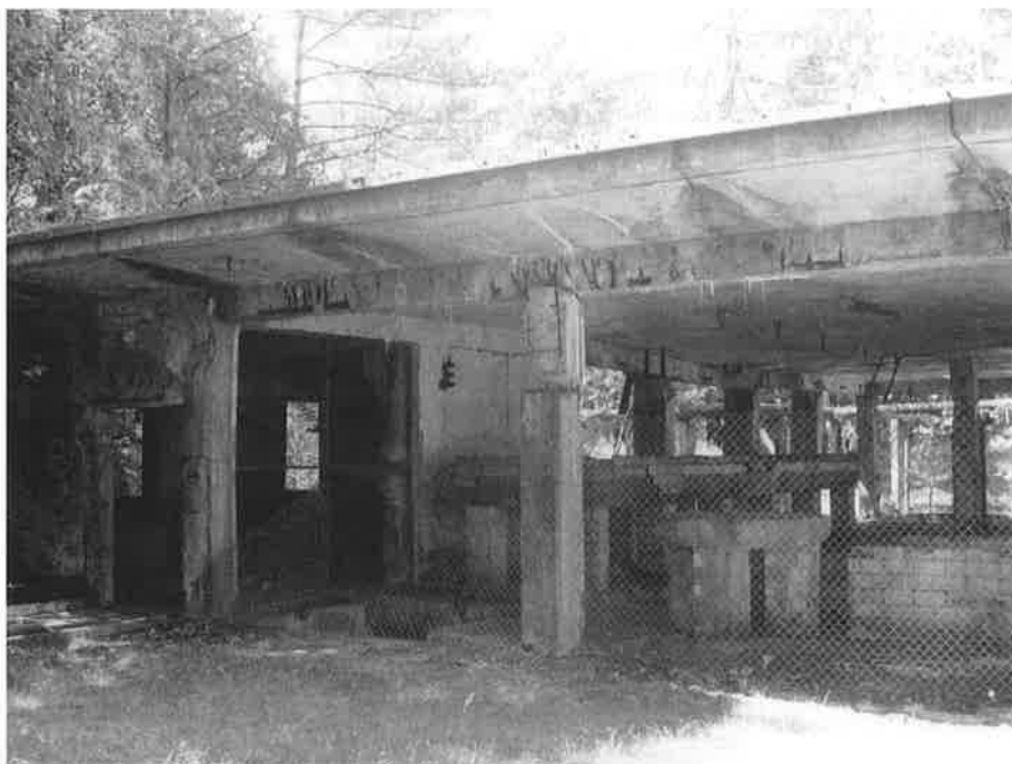
Gebäude der Pulverfabrik Liebenau im heutigen Zustand. Foto: Martin Guse.
