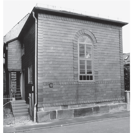
Außenansicht der Synagoge von Roth nach der Restaurierung 1998, Bildarchiv Foto Marburg, Archivnummer B 24875/8
