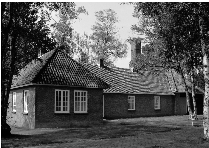
Erhaltenes Kremato- riumsgebäude
