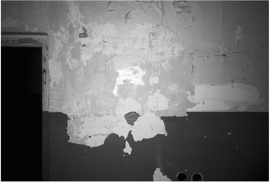
Baudenkmal KZ Dachau, Schubraum
