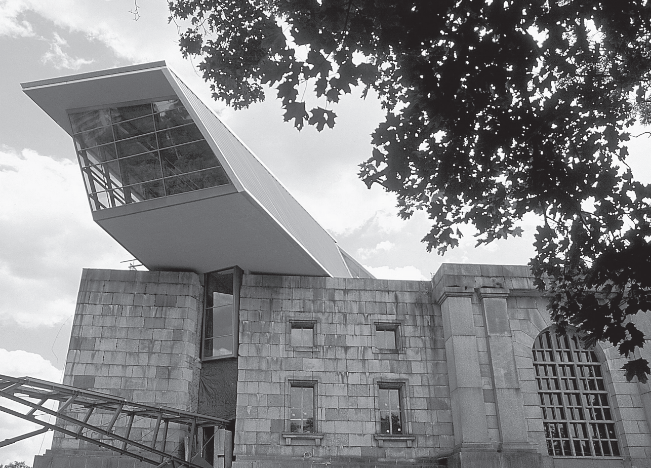
Eingang zur Ausstellung »Faszination und Gewalt«, sowie zum Dokumentations- zentrum und Reichs- parteitagsgelände Bild: museen der stadt nürnberg
