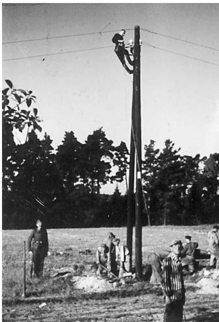
Das einzig erhaltene Foto von Häftlingen des »Arbeitslagers Lieberose« beim Arbeitseinsatz, auf- genommen vom Angehörigen des SS- Bauhofs Kurt Giese. Es zeigt Häftlinge beim Leitungsbau nach Ullersdorf im August 1944. Foto: Archiv Lieberose
