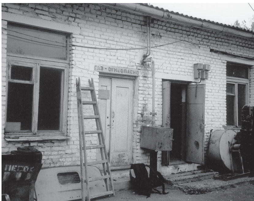
Rückansicht des Gebäudes. Mit der Instandsetzung wurde bereits begonnen. Foto: Gabriele Layer-Jung, 2002
