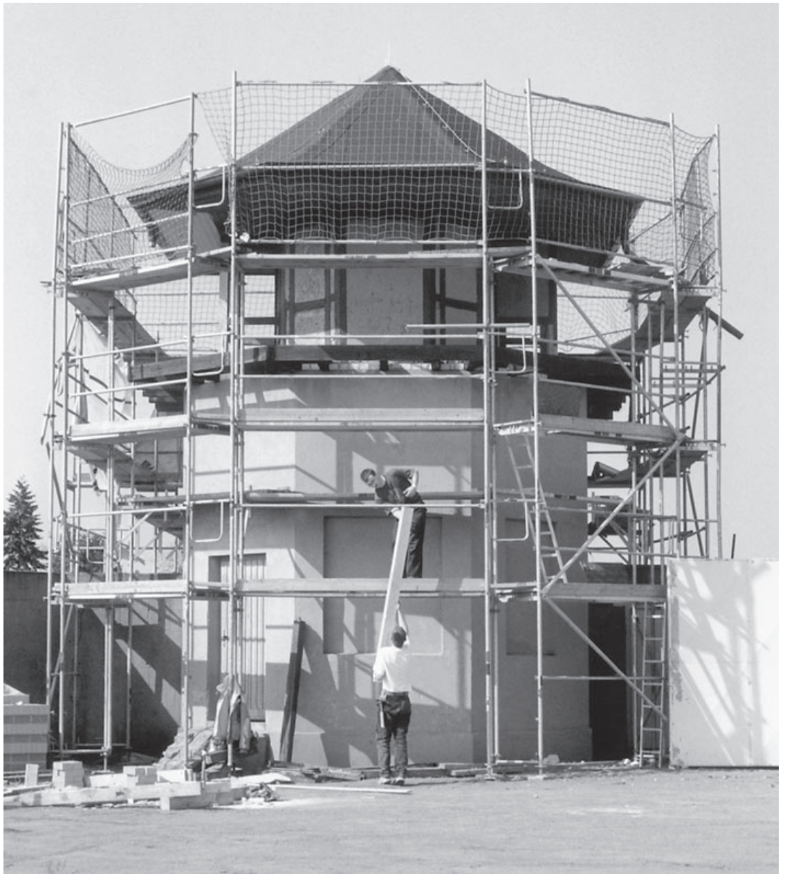
Dachsanierung des Wachturms an der Nordspitze des Lagerdreiecks im ehemaligen KZ Sachsenhausen. Hier wird eine kleinere Ausstellung zum Thema »Oranienburg und das Konzentrationslager« gezeigt. Foto: Stiftung Brandenburgische Gedenkstätten
