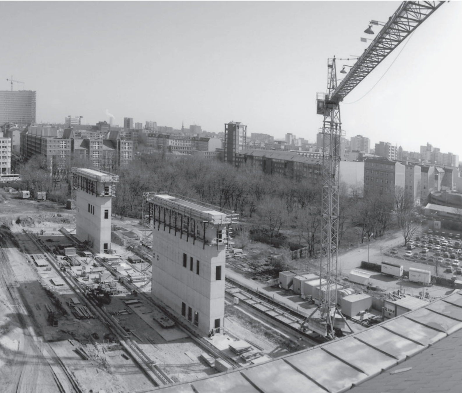
Baustelle Neubau Stiftung Topographie des Terrors vom Dach des Martin-Gropius-Baus aus gesehen, 1998. Im Foto links: Open-Air-Ausstellung, darüber Reste der Berliner Mauer. Fotos: Hans D. Beyer/Stiftung Topographie des Terrors
