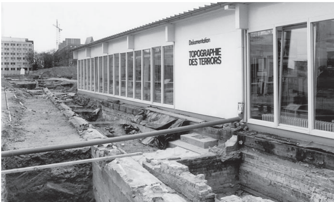
Das seit 1987 genutzte provisorische Ausstellungsgebäude während der archäologischen Bodenuntersuchungen. Im Vordergrund die Mauerfundamente für den Hof des Hausgefängnisses der Gestapo, 1997. Foto: Hans D. Beyer/Stiftung Topographie des Terrors
